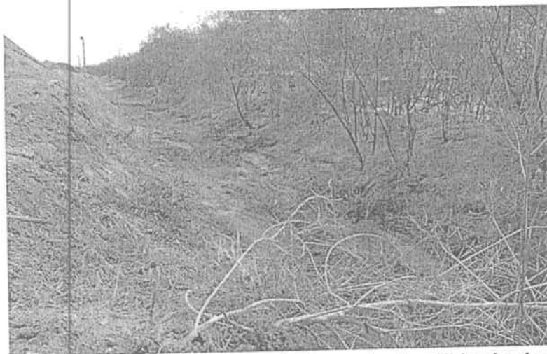
Fotografía No. 5 Canal en tierra para el control de arrastre de sólidos hacia el sedimentador.
